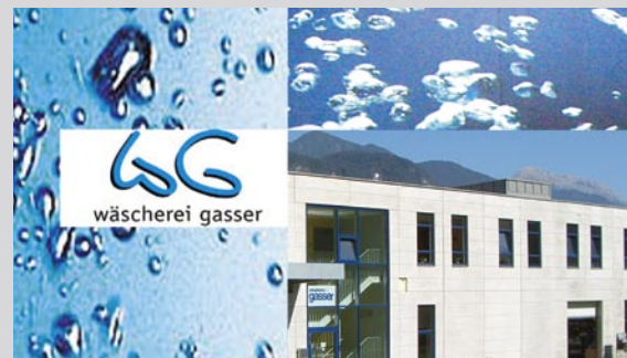
Wäscherei Gasser GmbH, Neubau Betriebsstätte, Flurling
